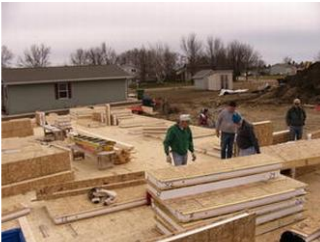
Рис. 12. Предмонтажная раскладка панелей
