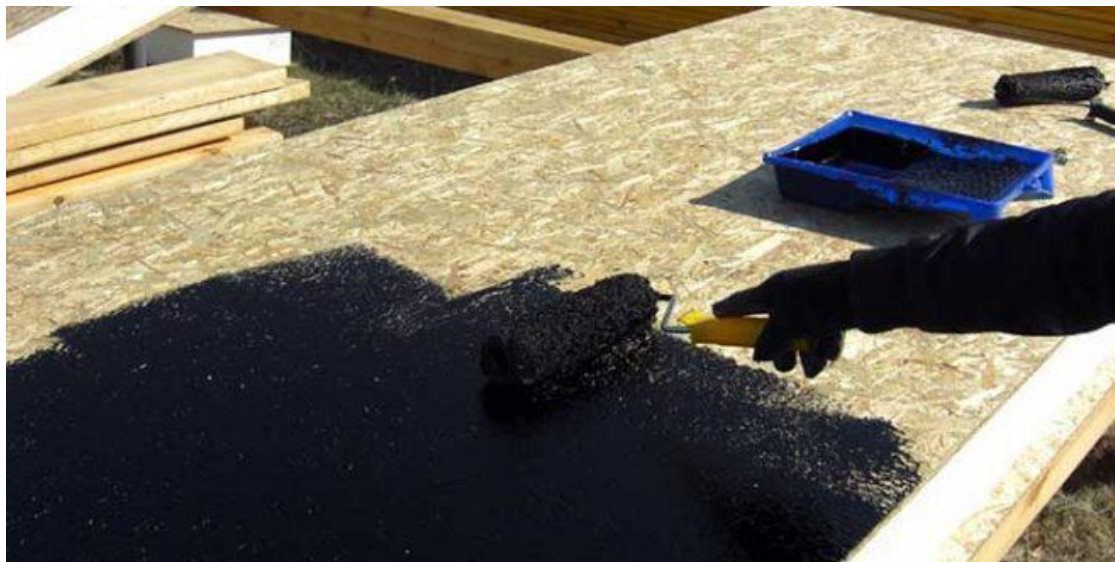
Рис. 13. Покрытие битумной мастикой
